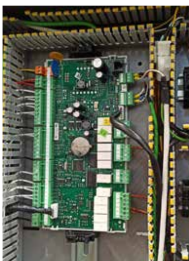
⑦a Detail Verbindung Platine µPC PLan
