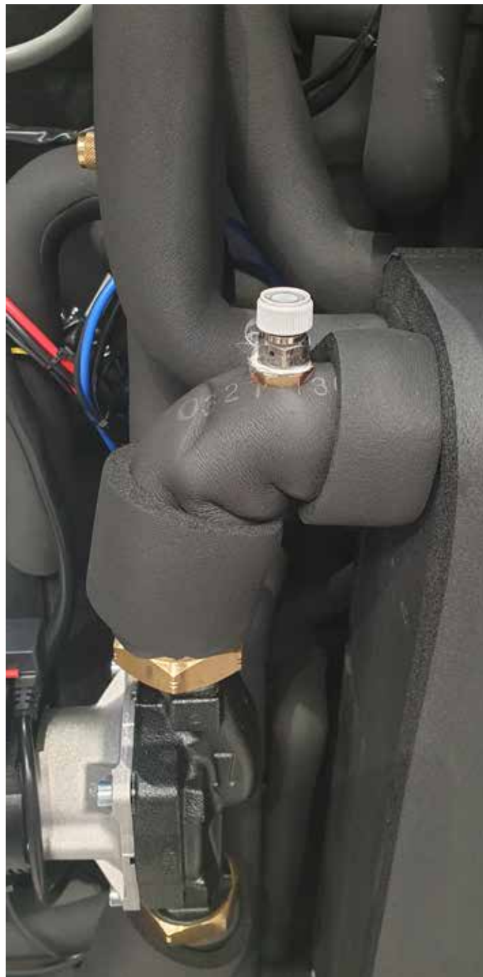
Entlüftungsventil, Monoblock Version.
