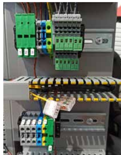
③ Detail Kabelkanal
